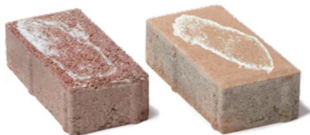
Dlažba s výkvětem
