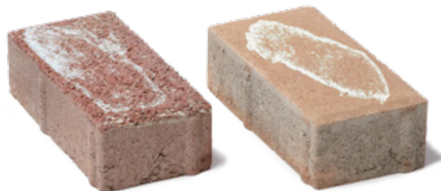
Dlažba s výkvětem
