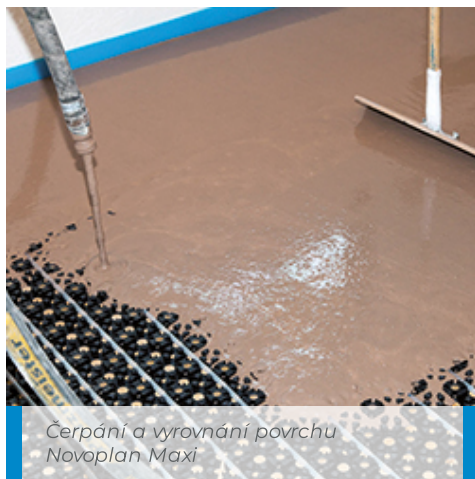
Aplikace směsi a vyplnění topných panelů tenkovrstvým systémem
