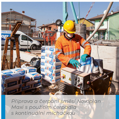
Čerpání a vyrovnání povrchu Novoplan Maxi
