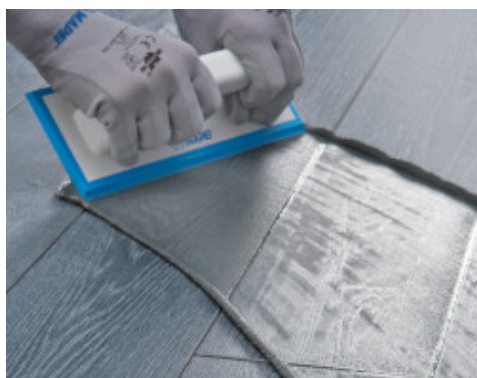
Nanášení Ultracoloru Plus gumovou stěrkou na dlažbu typu gres s efektem dřeva
