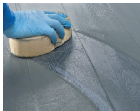
Čištění a konečná úprava spár tvrdou houbou z celulózy
