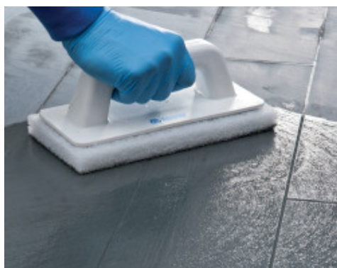
Čištění a konečná úprava spár s pomocí Scotch-Brite®
