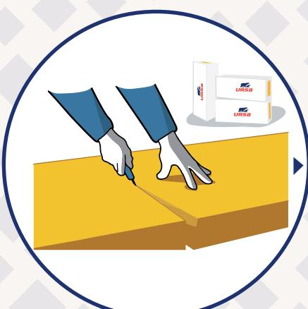
Odřízneme naměřenou část minerální izolace URSA. Řez provádíme podél přítlačné lišty (část OSB desky, kovový profil apod.) speciálním nožem URSA určeným k řezání izolace.
