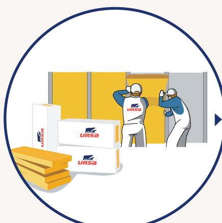
Aplikace minerální izolace URSA TWP 1 do připraveného roštu sádrokartonového systému. Izolaci do roštu vkládáme lehkým vtláčením po celé její výšce. Dutina roštu musí být vyplněna izolací po celé své výšce.
