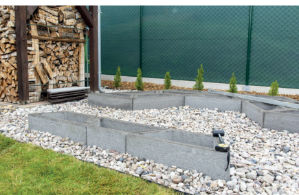
▲ Nejdůležitější je na samém začátku připravit si pevný a rovný základ
