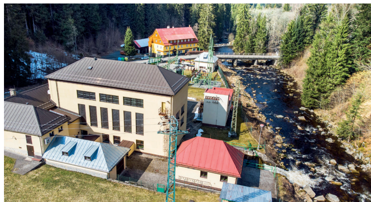
▼ Elektrárna Vydra využívající vodu tekoucí Vchynicko-Tetovským kanálem
