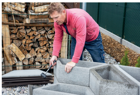
▲ Prvky se nelepi – stačí na sucho vyrovnat a je hotovo
