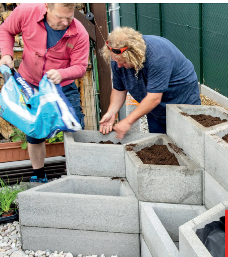
▲ Zásyp vhodnou hlínou
