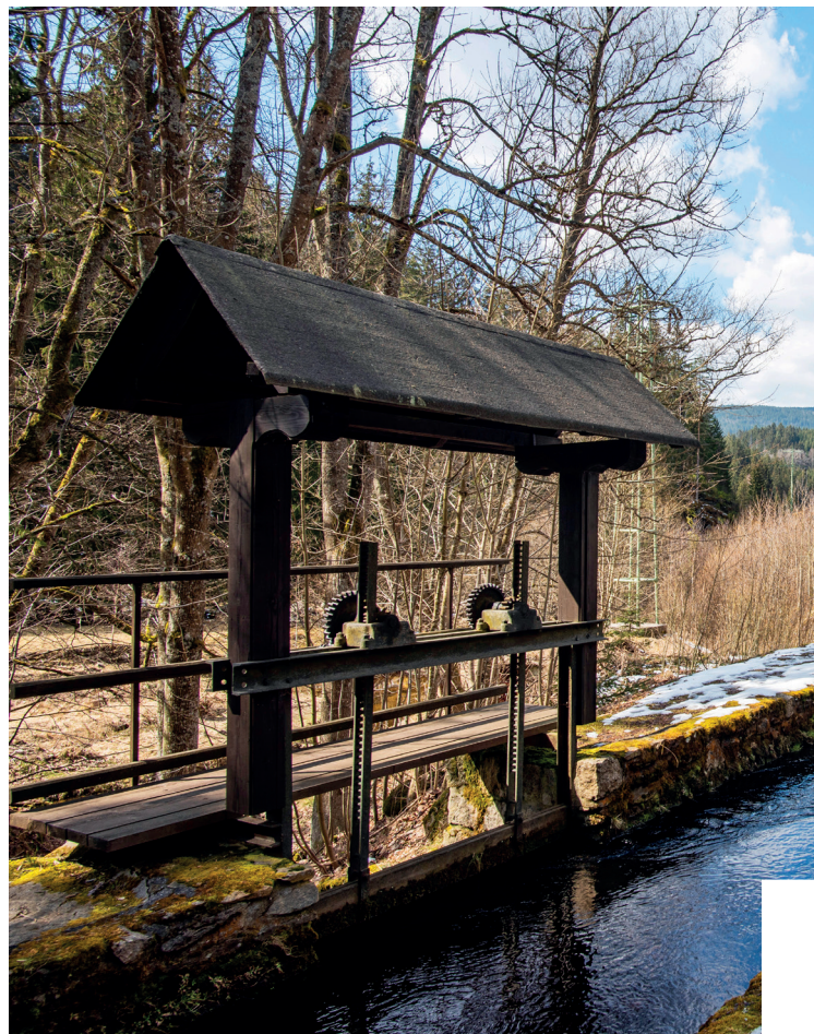
▲ Kamenným náhonem byla svedena voda z Vydry k Čenkově pile
