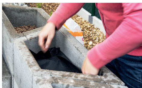
▼ Na vrstvu Liaporu (keramzitu) se dává separační fólie oddělující vrchní vrstvu hlíny
