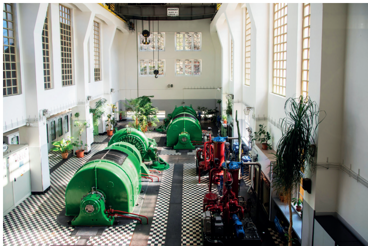
▲ Dvě Francisovy turbíny jedou na 1000 ot./min a spolykají přes 3 kubíky vody za vteřinu
